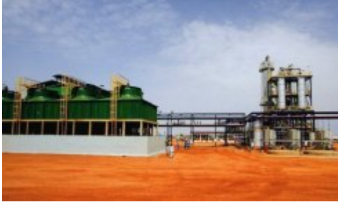
Une usine de bio-carburant à Kenana, à 250 km au sud de Khartoum, inaugurée en juin 2009
