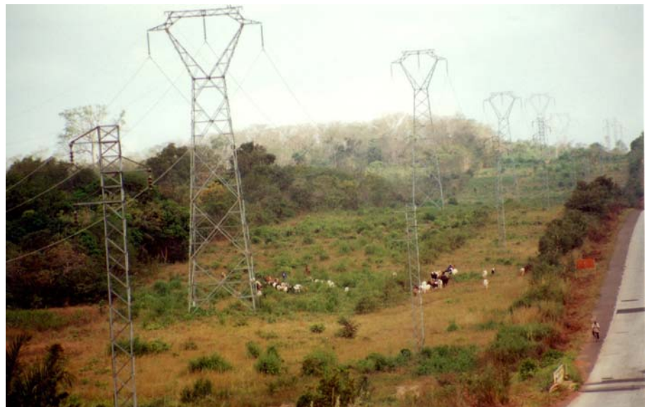
« drailles électriques »... (centre Côte d'Ivoire)
